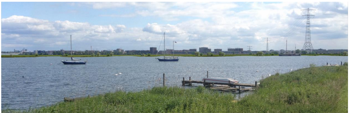
Uitzicht vanuit Durgerdam op nieuwe dijk buitenom
